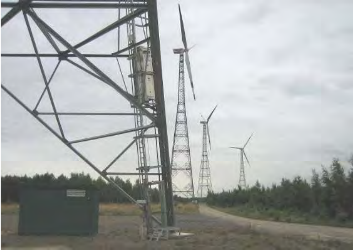
Kuva 10–29. Teräsristikkorakenteisia tuulivoimaloita Saksassa. (Kuva © TuuliWatti Oy).
