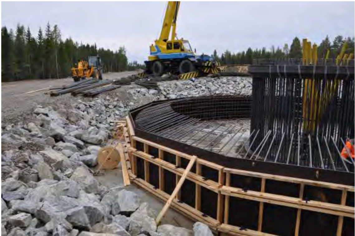
Kuva 6–4. Tuulivoimalan perustusten rakentamista kesällä 2011 Putaankankaalla Simossa.
